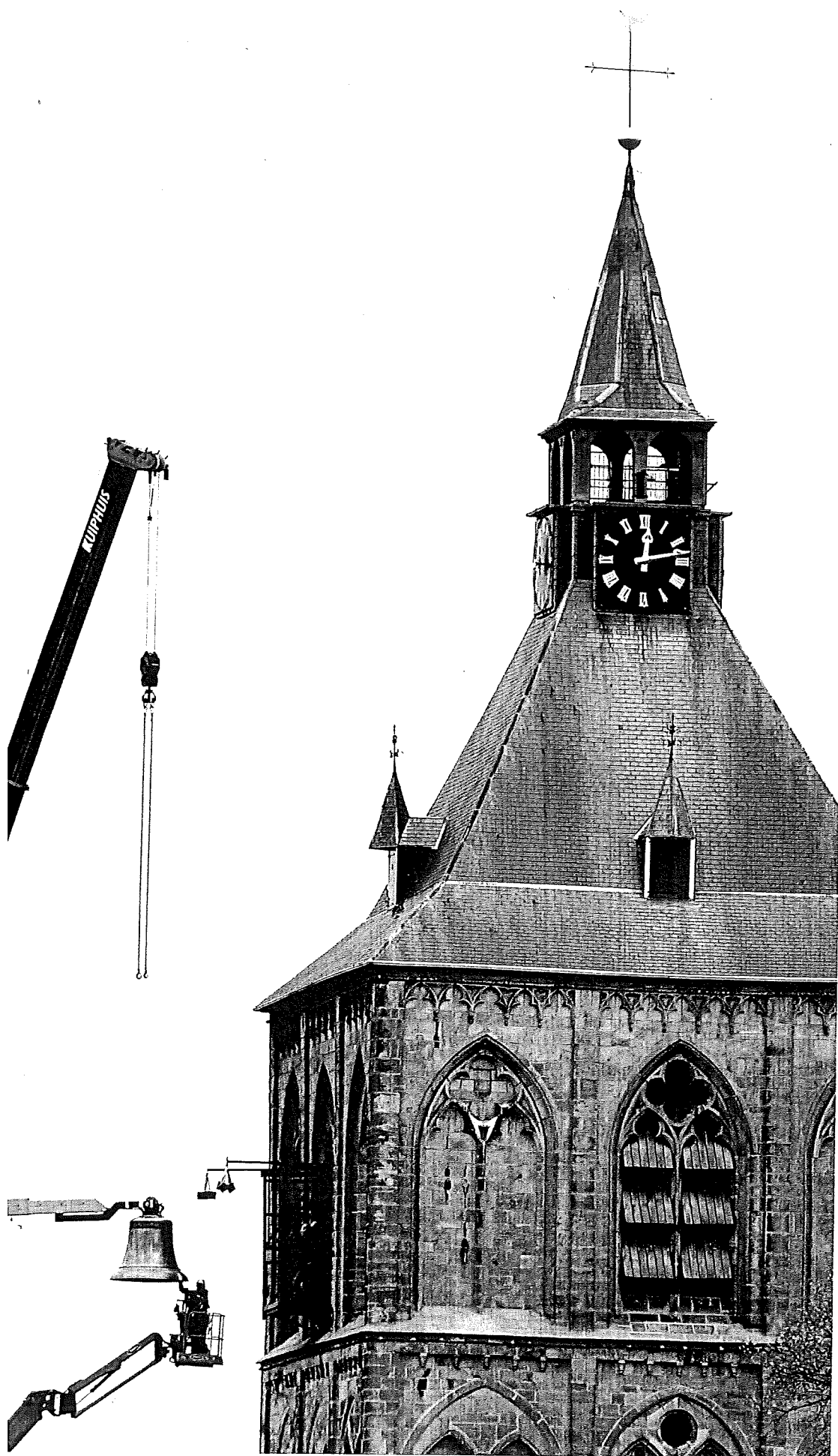
Met veel machtsvertoon van hijskranen werd de nieuwe klok in de toren getakeld. foto: Carlo ter Ellen
